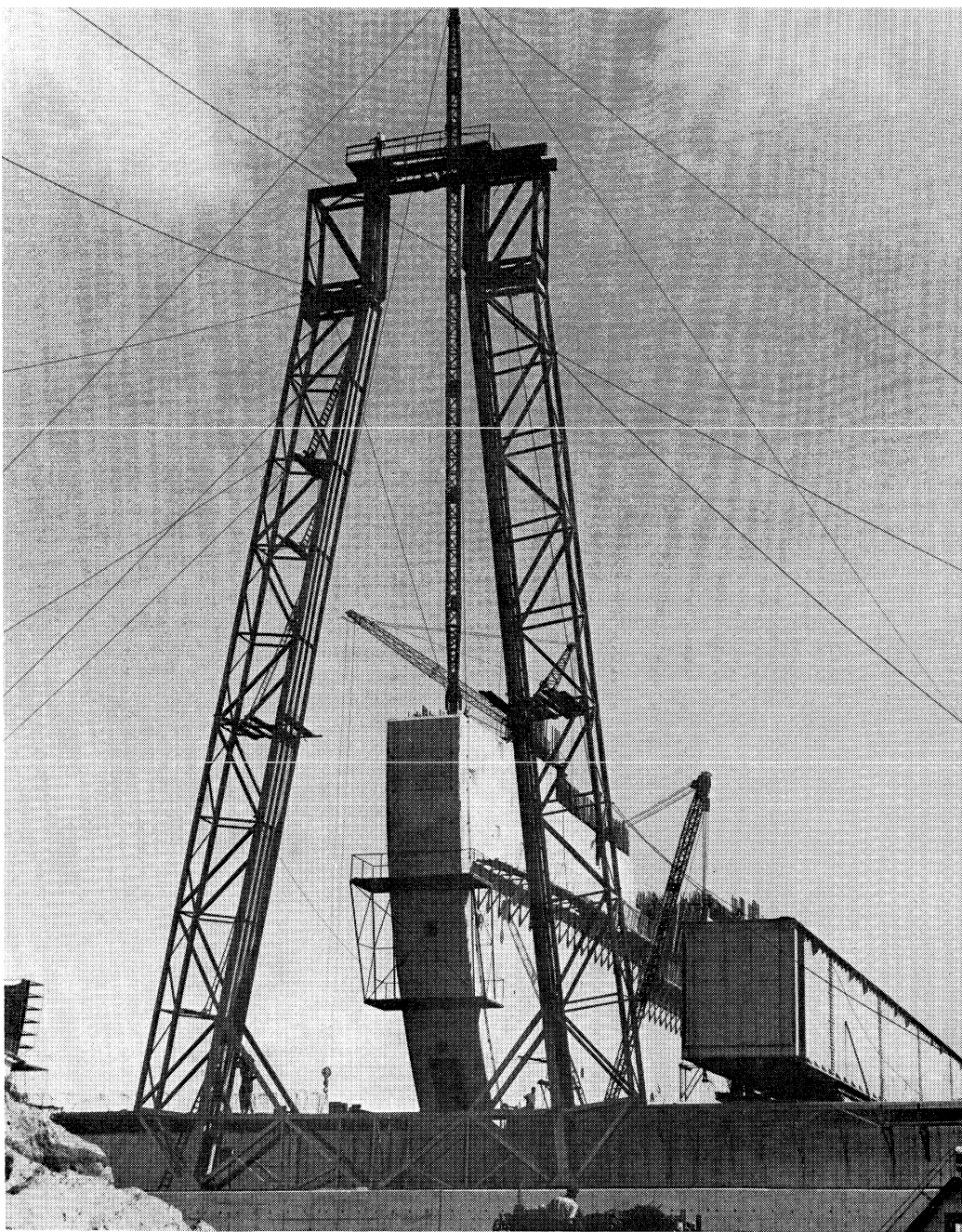
Montage van één van de verrijdbare poten van de 250 tons brugkraan; rechts de kokervormige constructie die aan de bovenzijde van de kraan dienst zal doen
