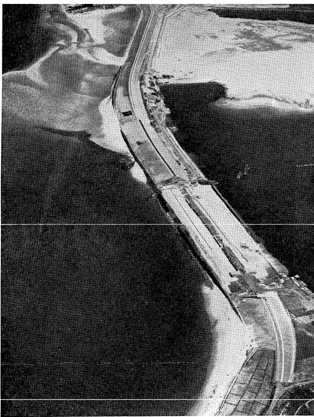
De afsluitdam door het Veersche Gat op 31-7-61; de doorlaatcaissons zijn nog zichtbaar
