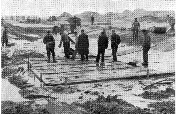
Het aanbrengen van de steengaasmatten
