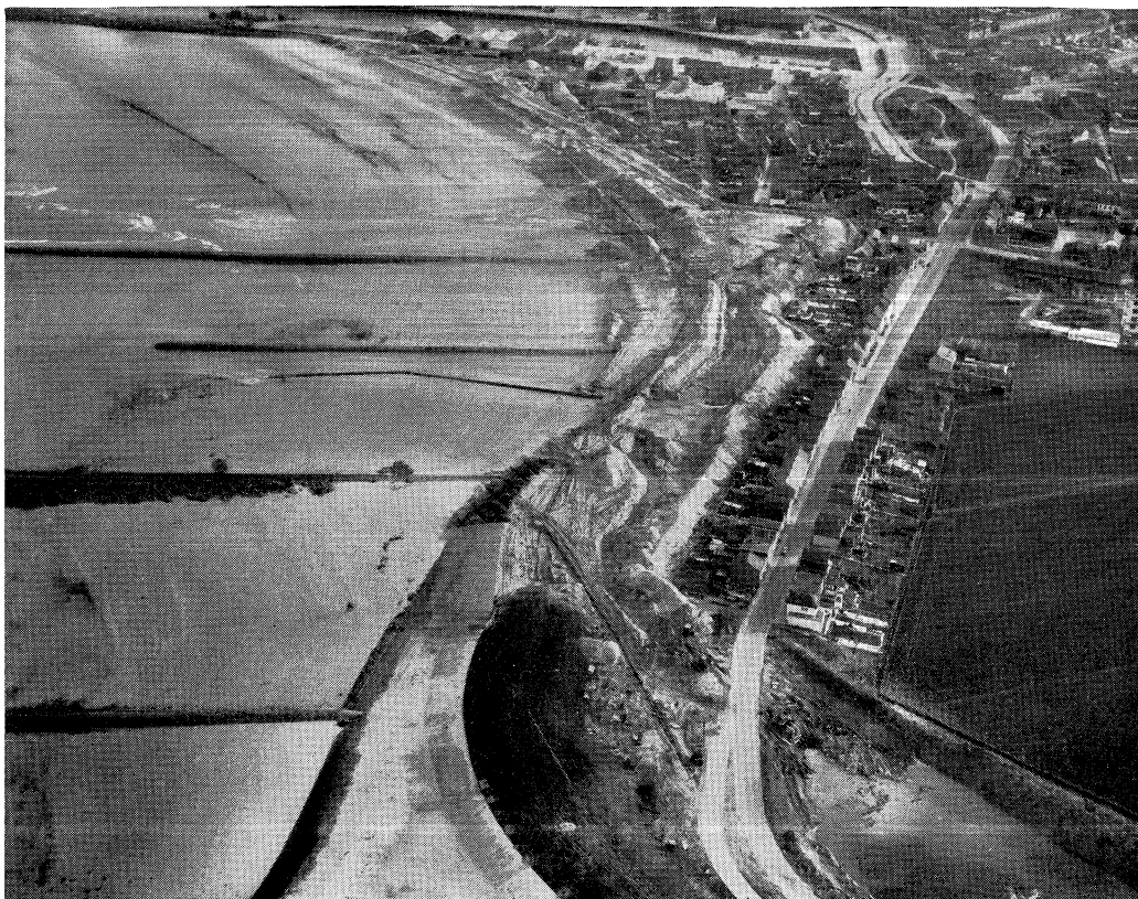
Overzicht van de duinverzwaring in uitvoering
