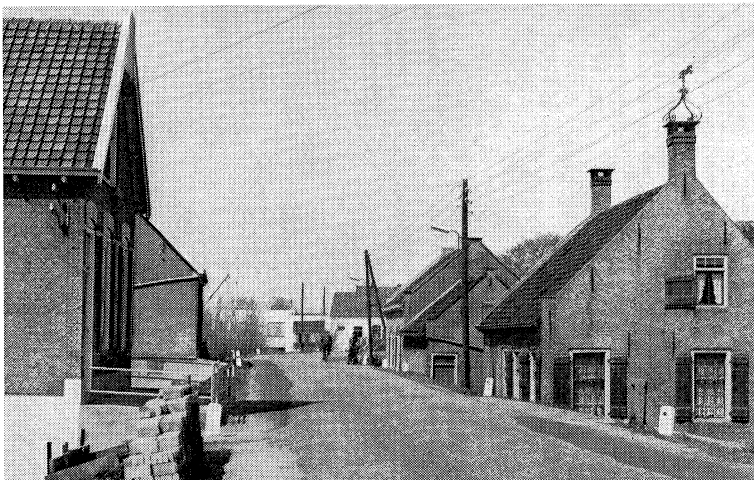
Dijkverzwaring gereed; de kruin is verhoogd en verbreed, de huizen aan de linkerzijde zijn opgevijseld
