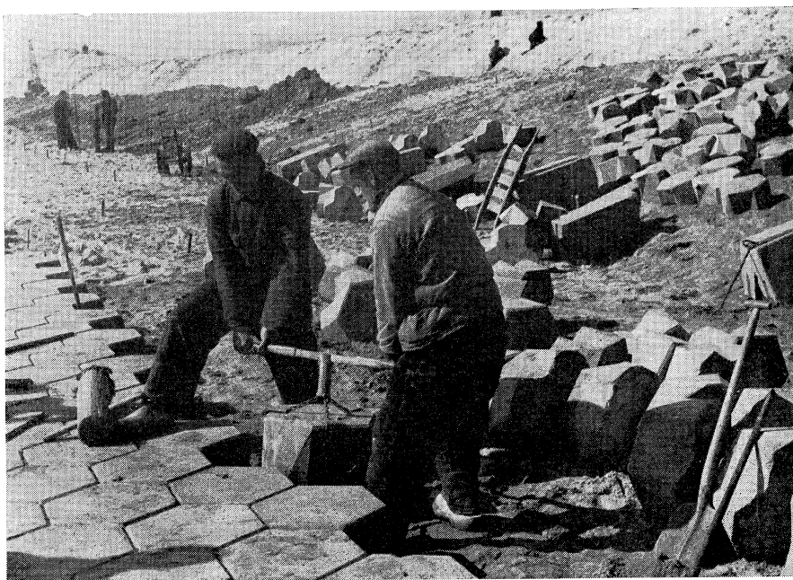
Het plaatsen van de betonblokken
