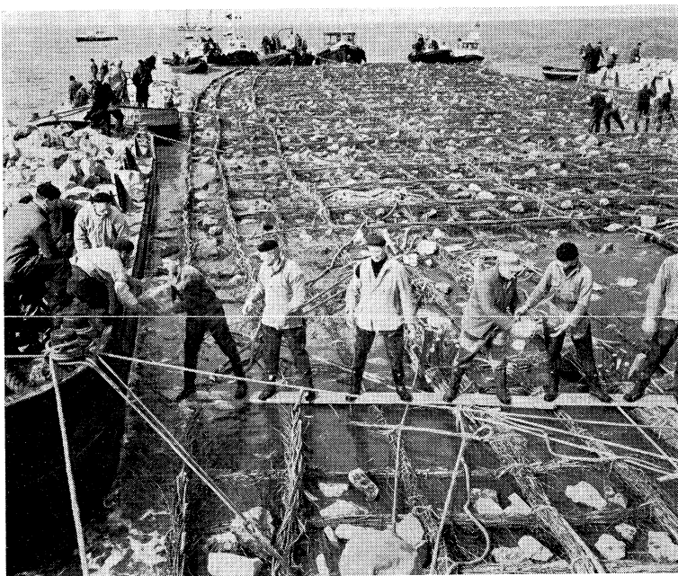
Het aanbrengen van lichte ballast
