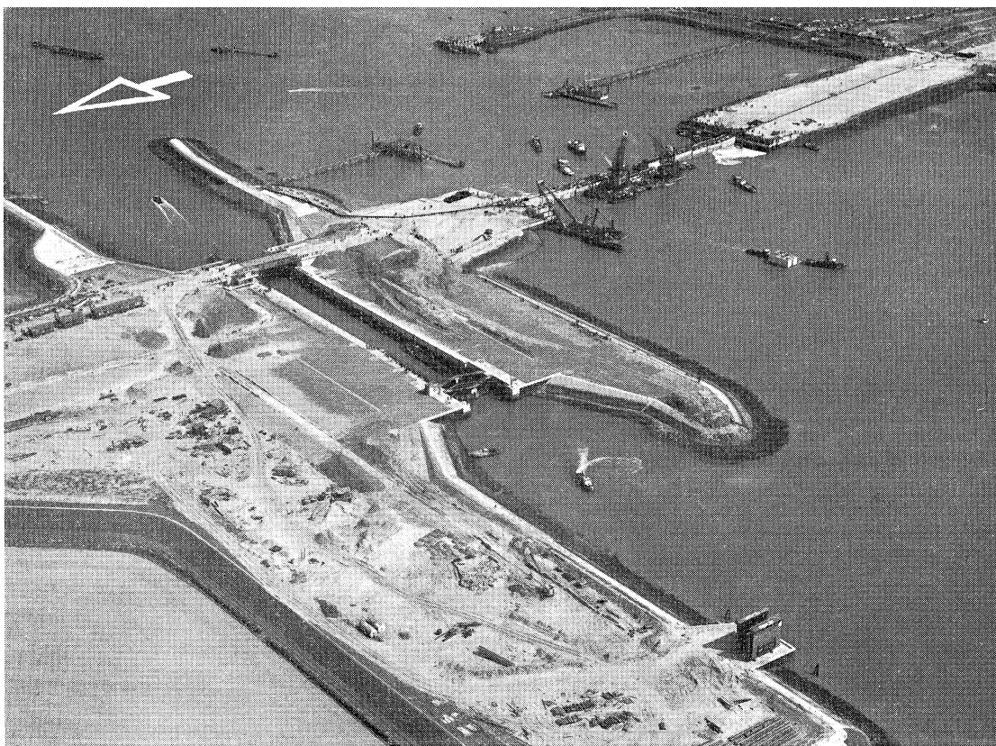
Overzicht van de afsluitingswerkzaamheden en van de voltooide schutsluis
