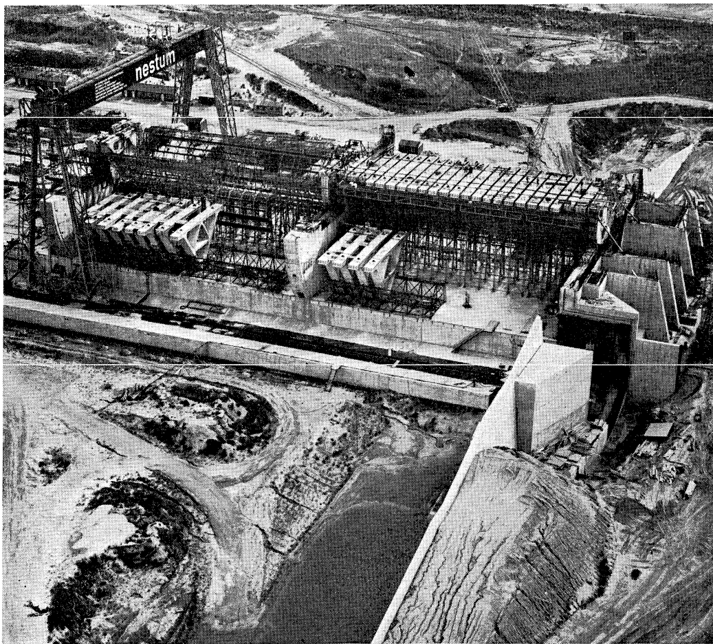
Montage van de nabaliggers op de zuidelijke vloervelden van de uitwateringssluis in het Haringvliet
