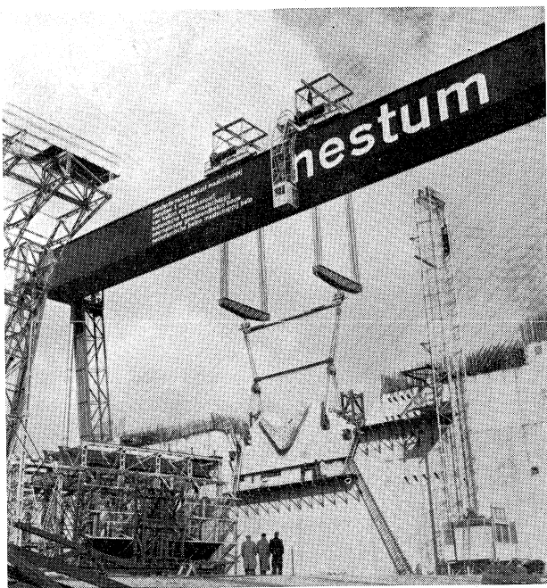
Het plaatsen van een eind-schotgedeelte van de Nablaligger
