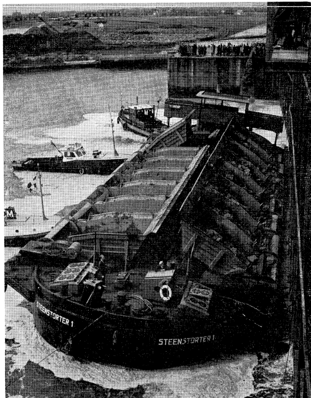
Aanbrengen van de bestorting tegen de caissons met behulp van de mechanische steenstorter
