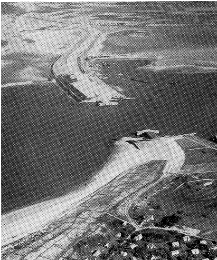
De sluitopening in de dam door het Veersche Gat
