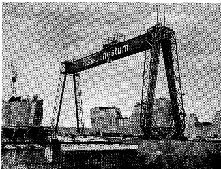
De verrijdbare brugkraan voor de montage van de naballiggers
