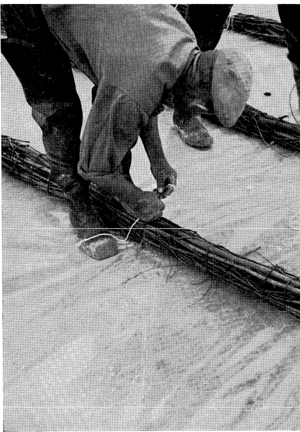
De wiepen worden op de plastic folie bevestigd
