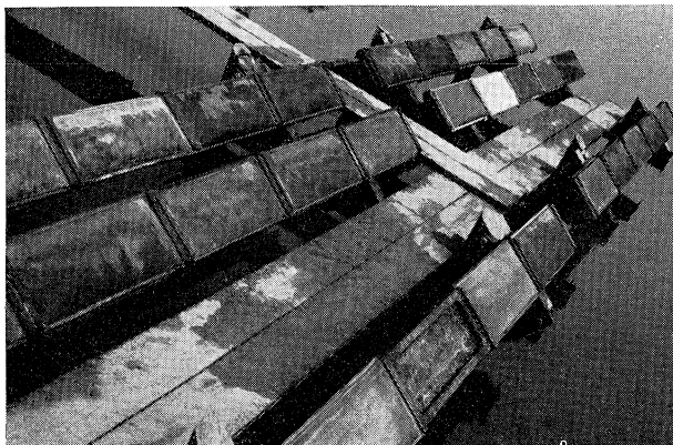
Overzicht van de proefopstelling op de waterlijn. De doeken zijn begroeid en bedekt met een laagje slib. Rechts op de tweede rij een nieuwe proefdoek
