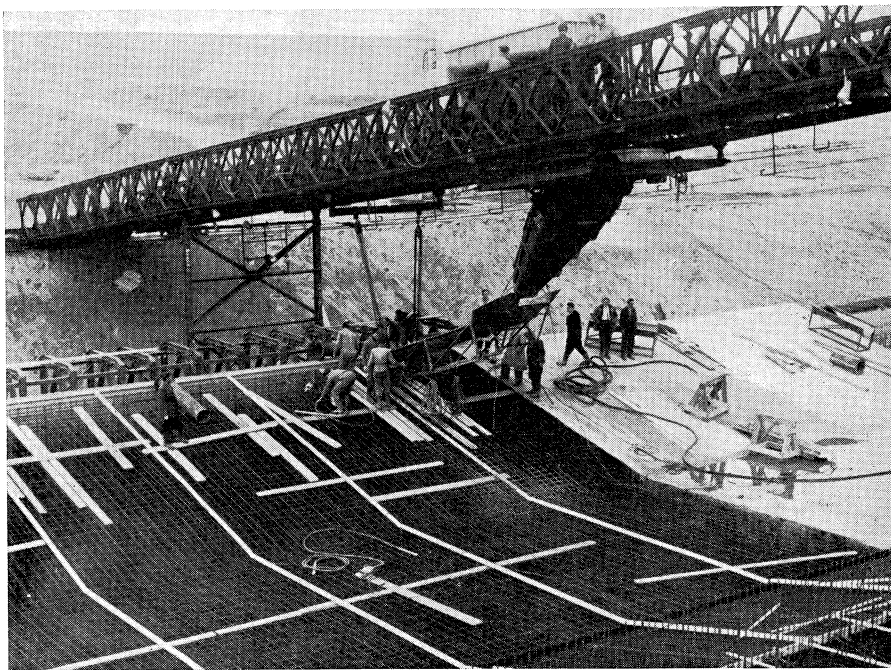
Het storten van de beton in de sluisvloer
