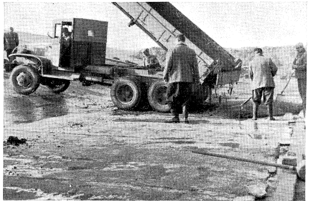
Het storten van de asfaltbeton
