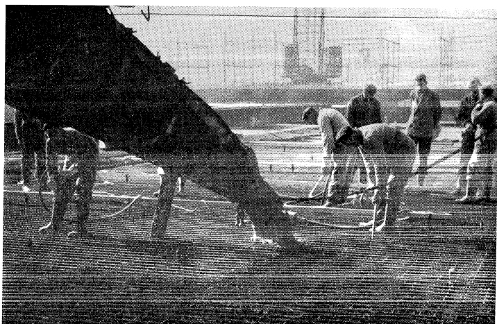
De aan de onderkant van de brug vrijdbaar bevestigde trechter brengt het beton in het vloerveld
