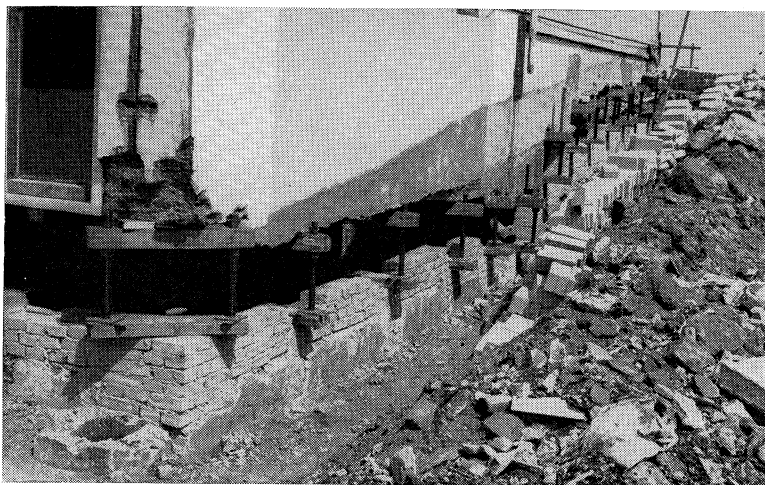
Met behulp van vijzels omhooggebracht huis
