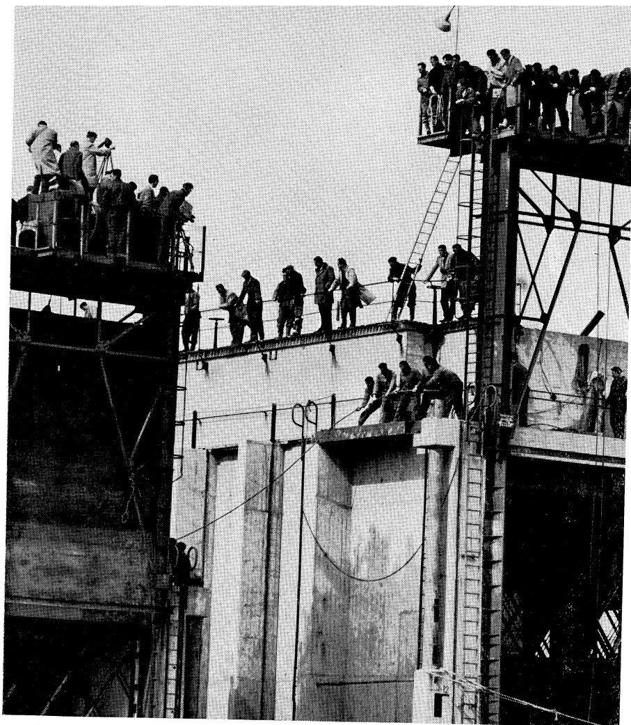
De zojuist ingedraaide laatste caisson wordt vastgemaakt aan een reeds gezonken element
