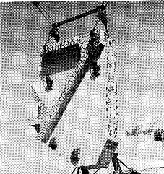
Een gekanteld eindschotgedeelte wordt opgelicht en getransporteerd
