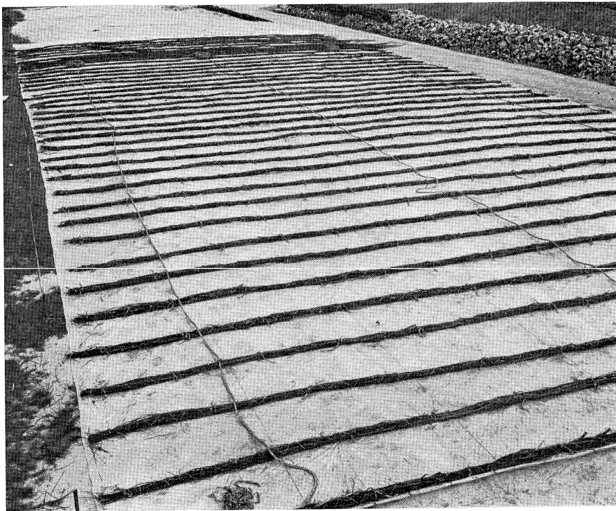
Een van de zinkstukken van polyaetheen die in de Grevelingen als bodembescherming worden toegepast
