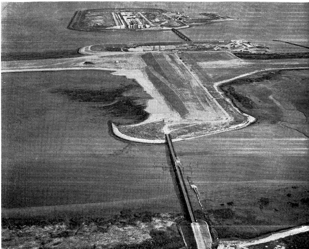
Zuidwestelijk van de grote bouwput in het Haringvliet werd een aantal grondwerken uitgevoerd. Daartoe behoorde o.m. het op hoogte brengen van de toerit naar de schutsluis (midden)
