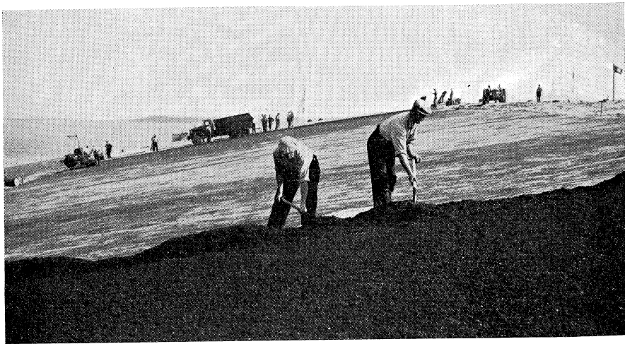
Aanbrengen van asfaltbeton op het buitentalud
